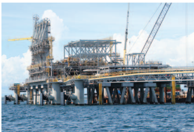
Plate 2.5 – The five liquid loading arms on the LNG jetty
