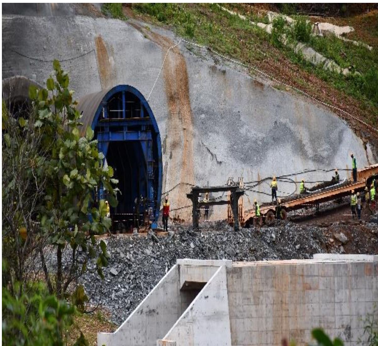
Tunnel de 903m en construction par SIMFER entre Bangalidou et Niosomoridou Centre
